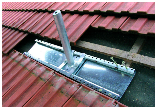
obr. 2.12 ukázka kotvicího zařízení typu A a C určeného k upevnění na dřevěnou konstrukci
