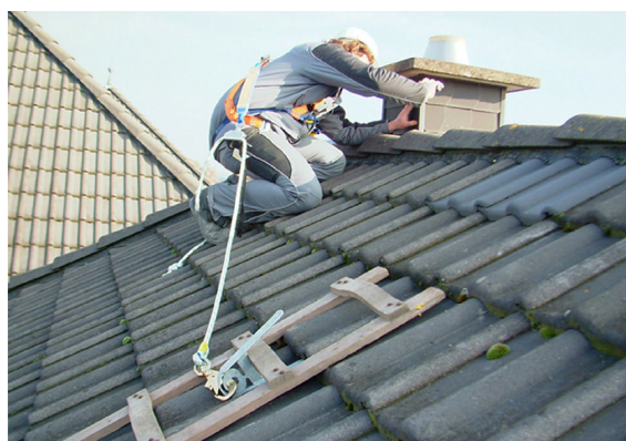
obr. 2.46 Bezpečnostní střešní hák dle ČSN EN 517 s položeným žebříkem
