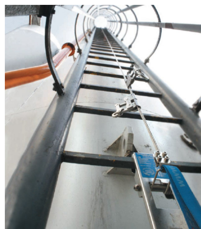
obr. 2.23 Ilustrační foto lanové vedení při výstupu po žebříku
